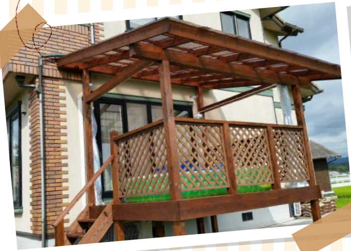
O様邸 ウッドデッキ設置工事
